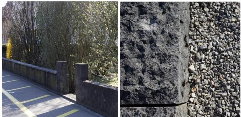
Sockelmauern und Sitzmauern aus Beton, Oberfläche rau;
