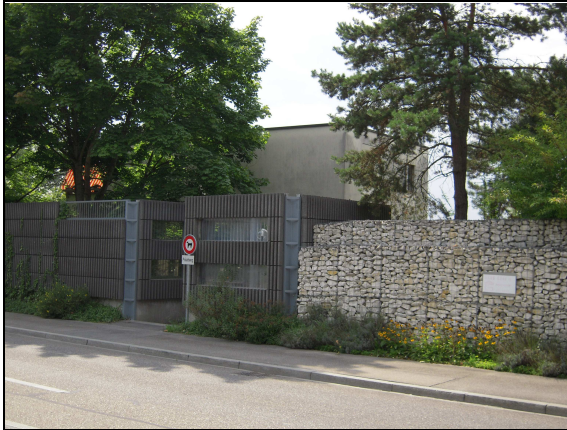
Lärmschutzwand und Steinkorb-Mauer beim Fussweg
