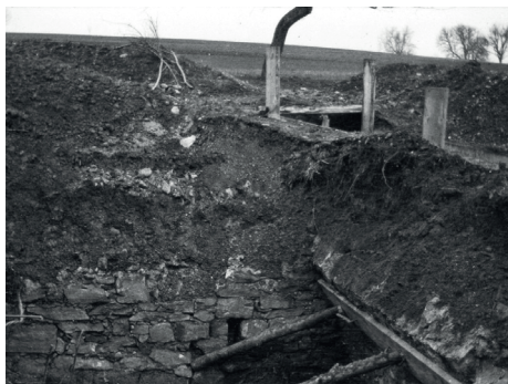
Bild links: Brunnstube beim alten Reservoir. Bild rechts: Quellenfassung beim alten Reservoir.
