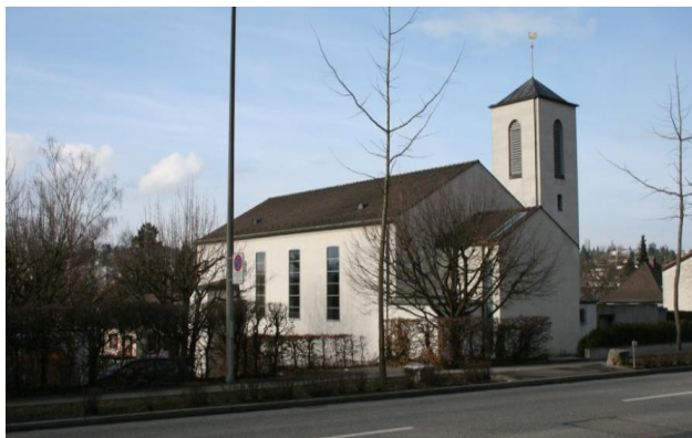
Abb. 3: Kirche, Blick von Südosten
