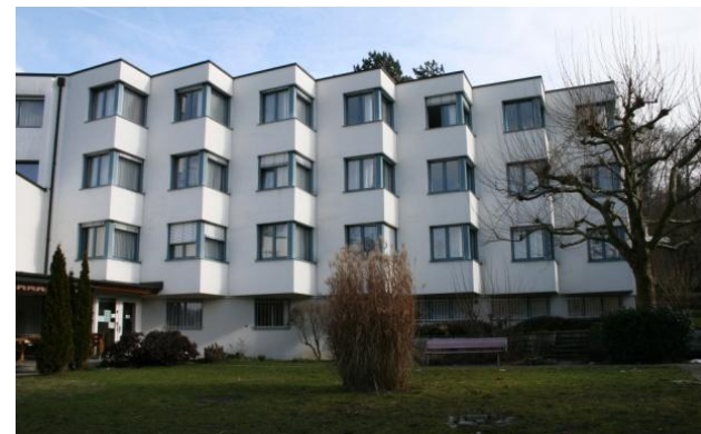
Abb. 4: Altersheim, Blick von Westen
