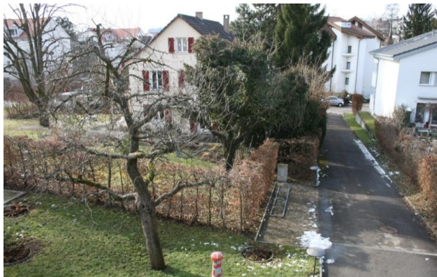
Abb. 2: Pfarrhaus, Blick von Osten
