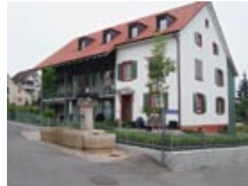
Spektakulärer Umbau des Zihlmannhofs an der Schmiedengasse
