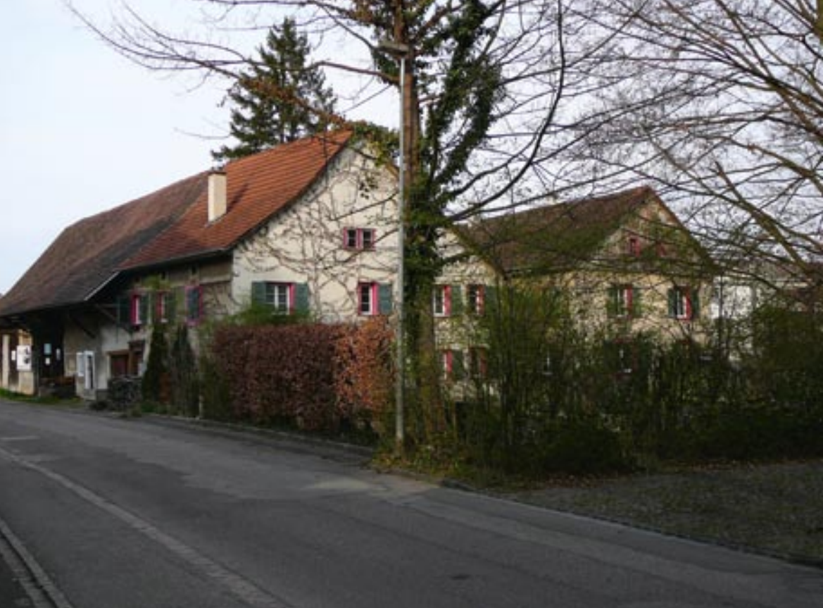
Alter und neuer Eckpunkt an der Konsumstrasse. Im Gebäude Konsumstrasse 1 befindet sich eine Pflegewohnung des APH Dreilinden.
