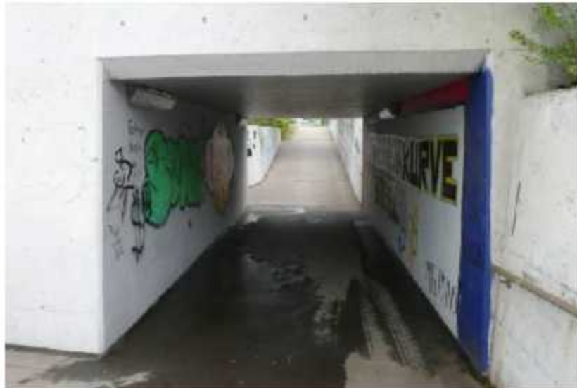
Unterführung Hüslimatt, Oberwil
